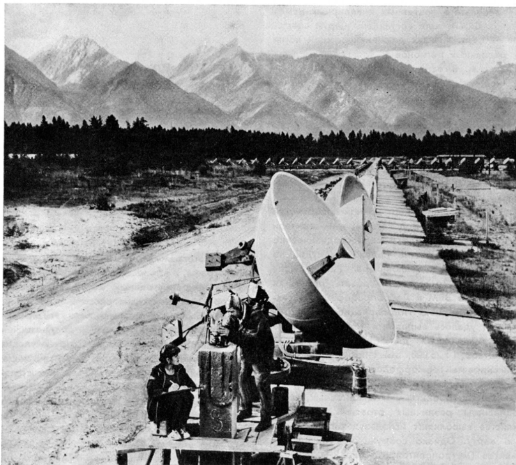
Юстировку Сибирского солнечного радиотелескопа (Бурятская АССР) ведут геодезисты ГУГК СССР
